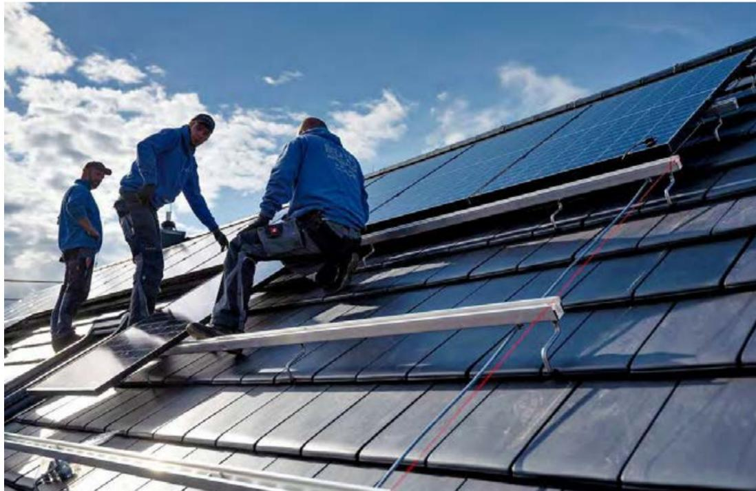
Photovoltaikmodule werden auf dem Dach eines Wohnhauses montiert. Am besten ist es, kompakte Flächen anzulegen.
